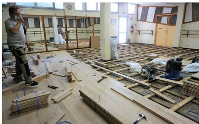
5. À la Maison Pour Tous , un nouveau plancher a été posé dans la salle de danse.
