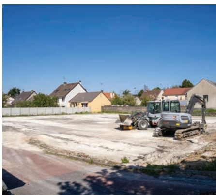
6. Les courts de tennis situés près du gymnase Aubertin ont été détruits. Ces travaux de démolition préparent la place à la future construction d'une salle de gymnastique.
