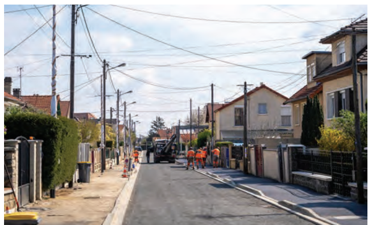
7. Rue Massenet, après des travaux d'assainissement de la Communauté d'agglomération: réfection des trottoirs et de la chaussée. Pose de nouveaux lampadaires à Led.
