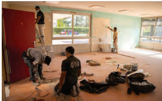
2. À l'école maternelle Célestin Freinet , remise en état de la peinture et remplacement du sol dans la classe 4.
